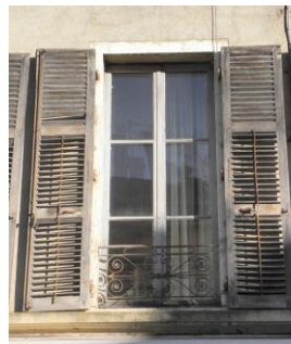
modèles courants XIX e début XX e : 2 vantaux ouvrant à la française, partition des vitrages plus hauts que larges. Occultation par volet bois avec persiennes à lames orientables.
