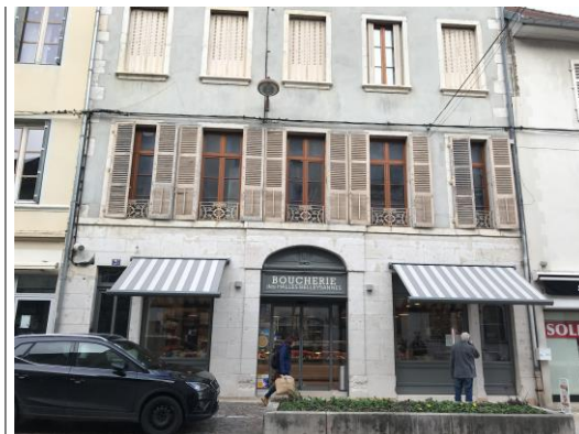
Grande Rue-25_soubassement en pierre de taille, au dessus murs en pierres non appareillées recouvertes d'un enduit.
