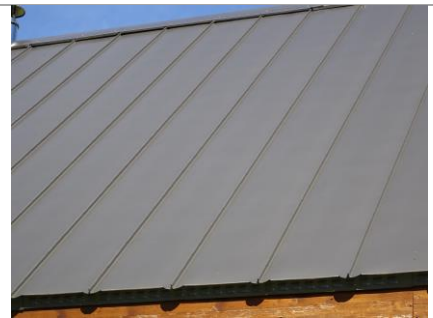
Tôle plane à joints debout
