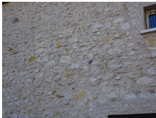
L'enduit à pierre vue n'est pas admis pour les façades sur rue
