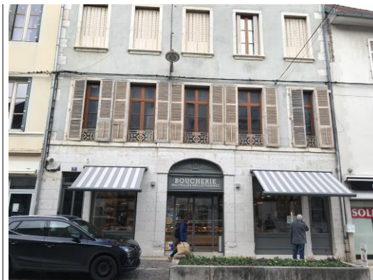
Grande Rue-25_Le rez-de-chaussée (soubassement) en pierre de taille est protégé par un badigeon, au dessus le mur en pierres non appareillées est recouvert d'un enduit.
