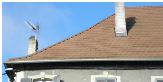
Tuiles plates rectangulaires à emboitement, petit moule, coyau en bas de versant
