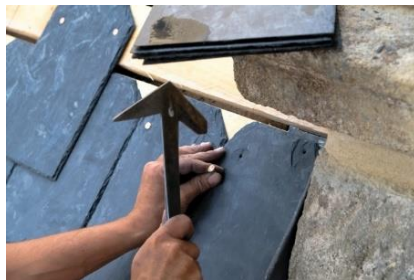
Ardoises naturelles sur volige posées au clou, mise en œuvre plus pérenne.
