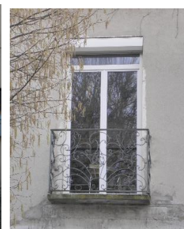
NON : Les coffrets de volet roulant diminuent la surface vitrée. Les montants en pvc blanc sont inadaptés au style architectural de ces bâtiments par leur dessin, par leur épaisseur et par leur couleur
