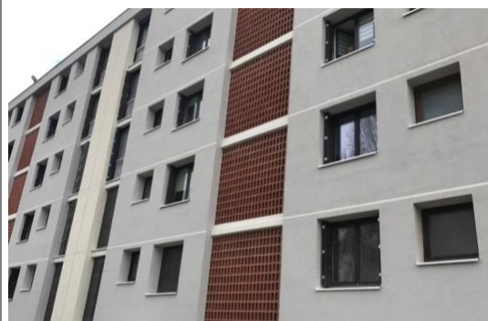
Copropriété réhabilitée Bourg-lès-Valence 26. ITE avec joints creux, conservation des claustras
