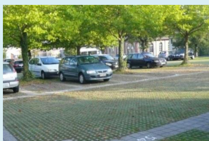
Stationnement en dalles alvéolées enherbées (Suisse)
