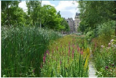
Noues, fossé humide, bassin biotope collectent en surface les eaux pluviales avant infiltration dans le sol, voire Collecte et traitement des eaux pluviales par un dispositif de filtration végétalisé (noues, bassin, jardins filtrants).
