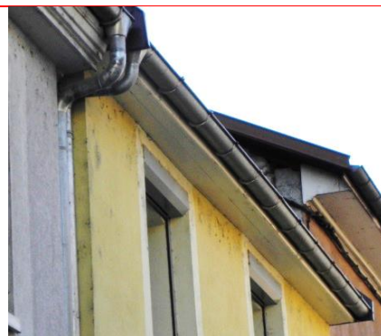
NON : diminution de la profondeur de la rive de toit due à l'isolation extérieur
