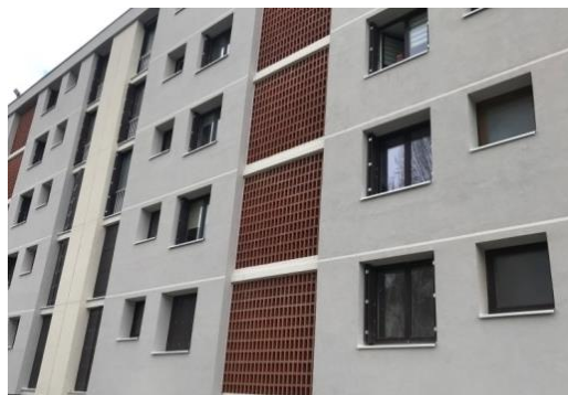
Copropriété réhabilitée Bourg-lès-Valence 26. ITE avec joints creux, conservation des claustras
