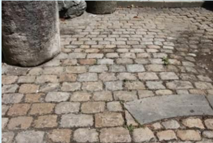
Pavés non jointoyés (Vienne)
