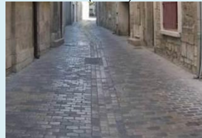
Pavés rejointoyés avec caniveau central
