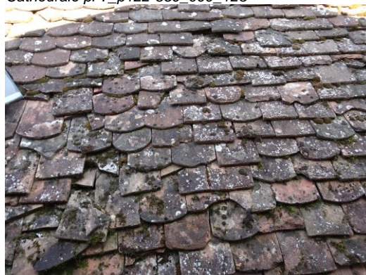
Tuiles plates traditionnelles, à petit moule, on distingue en mélange sur ce vieux toit : des tuiles écaille, des tuiles rectangulaires, des tuiles en queue de castor
