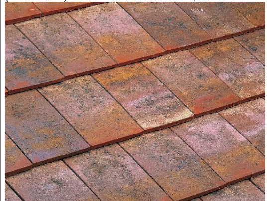
Tuiles plates à emboîtement, à petit moule, rectangulaires (22 tuiles/m²). Dimensions courantes 23,5/32cm
