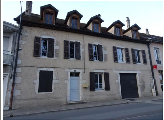
Volets battants, persiennés avec mécanisme. Alsace Lorraine Av-15_p129_277
