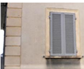
Enduit à la chaux sur moellon de pierre, pierre de taille en chaîne d'angle ou modénature en ciment moulé (chaîne d'angle et encadrement de fenêtre)
