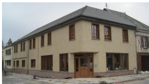
Isolation par l'extérieur de cette extension d'auberge en chaux-chaivre projeté_lucieetcharly.com
