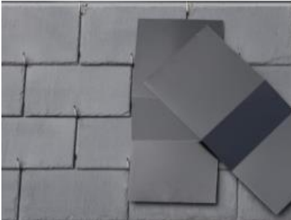
Ardoises naturelles sur volige posées au crochet
