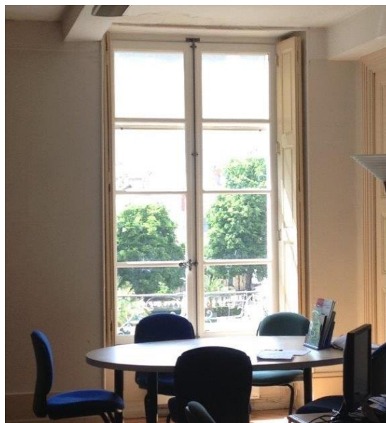
Grenoble. Le vitrage mince a permis de conserver les fenêtres XIX e avec leur serrurerie
