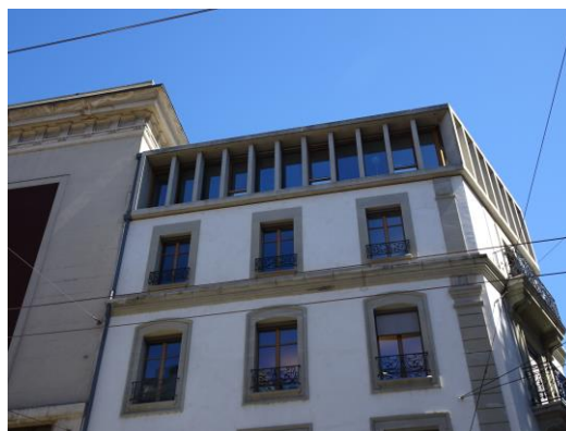
Un cordon formant corniche peut marquer la différence entre la partie ancienne et la nouvelle. Dans ce cas un attique peut être entièrement vitré comme ci-dessus. Genève CH
