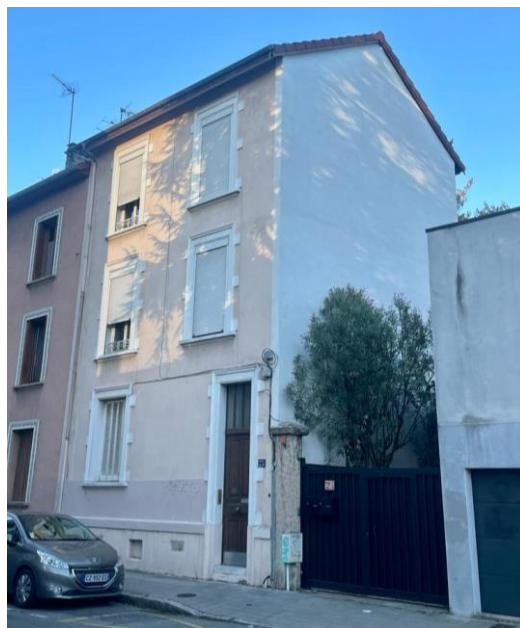
Pignon aveugle isolé avec du liège, Grenoble
