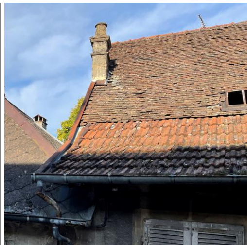
Coyau en bas de pente. La partie basse de ce toit a été refaite en tuiles mécaniques
