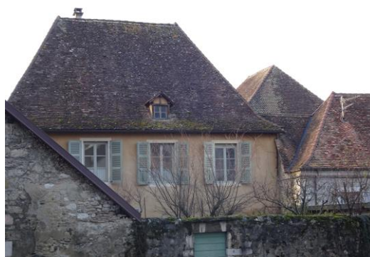
Tuiles écailles traditionnelles, coyau en bas de versant Cathédrale pl-7_p122-859_099_123
