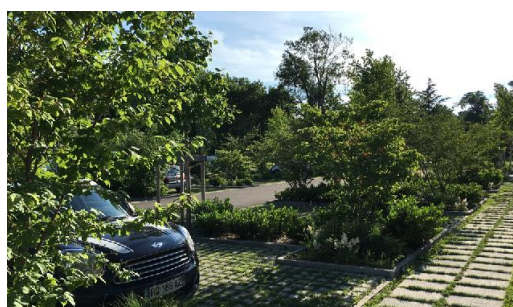
Stationnements perméables (pavés et joints enherbés) et planté (arbres)
