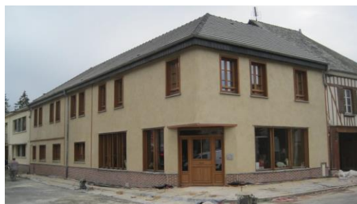
Isolation par l'extérieur de cette extension d'auberge en chaux-chanvre projeté_lucieetcharly.com
