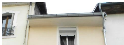
NON: Rigidification due au matériau (lattes en pvc ou « frisette ») de teinte trop contrastée en blanc pur
