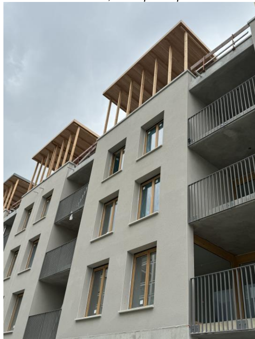
Fenêtres en bois, garde-corps des loggias en métal, Grenoble (38) chantier en cours
