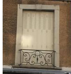
OUI: Volets persiennés métallique ou volets pleins en bois à panneaux
