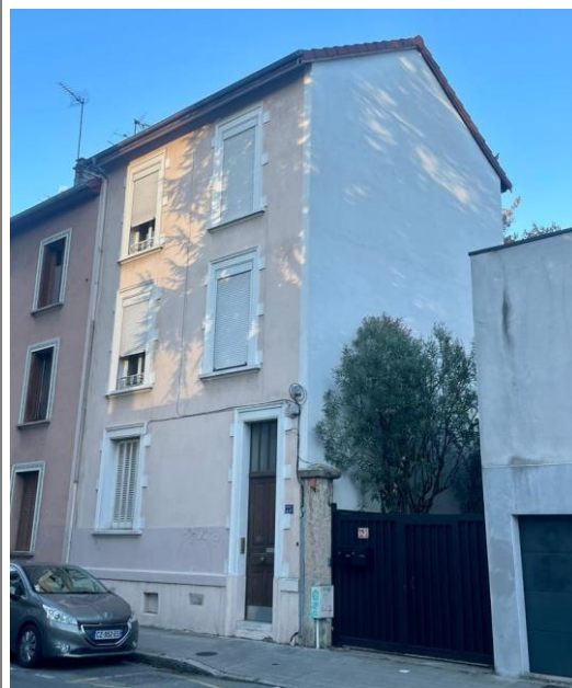
Pignon isolé avec du liège, Grenoble
