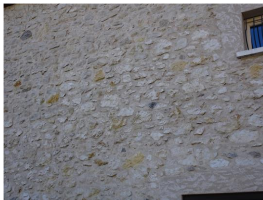
L'enduit à pierre vue n'est pas admis pour les façades sur rue
