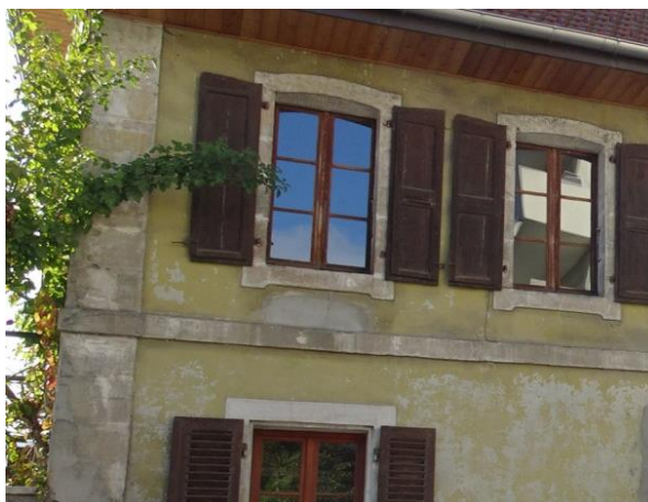
Modénatures discrètes qui disparaîtraient sous des panneaux ITE
